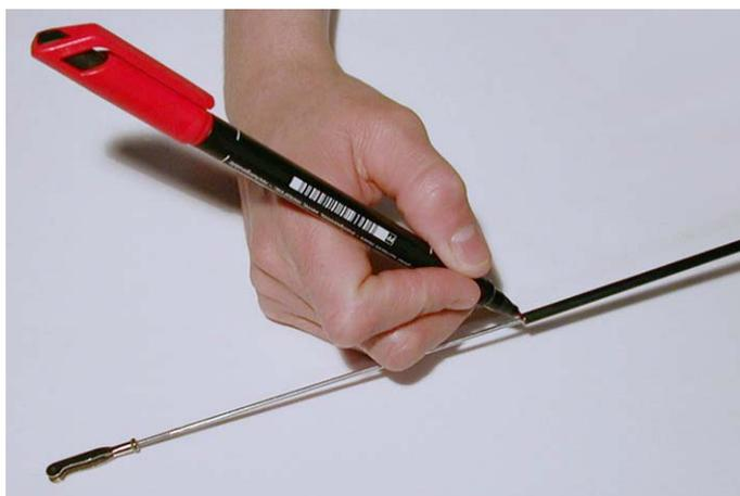
**Fig.72:Segnare la posizione di inserimento dell'asta.**
